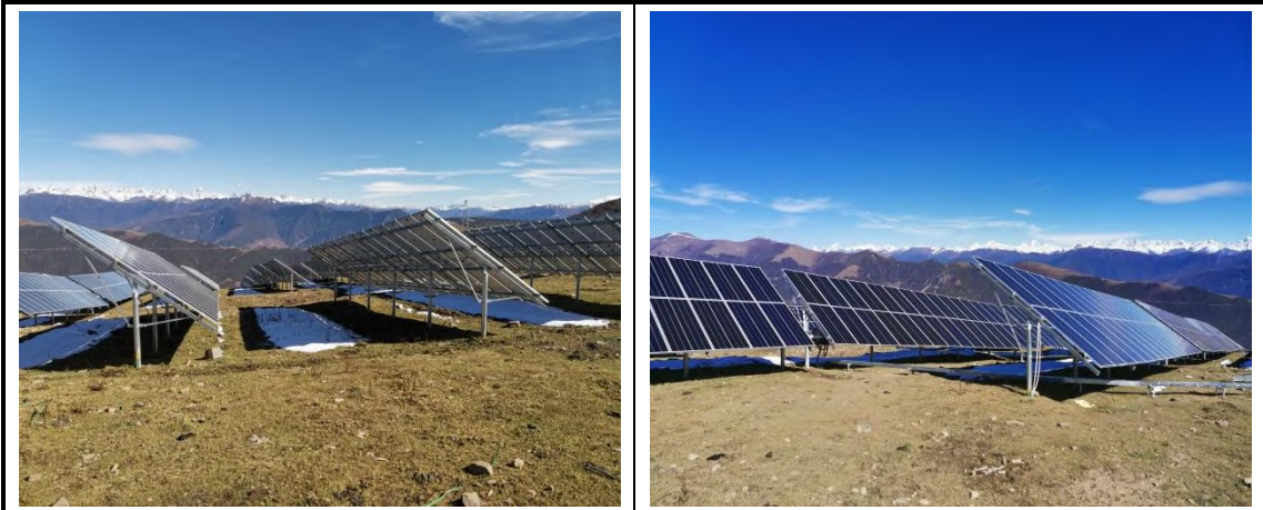
光伏阵列工程区植被建设工程
