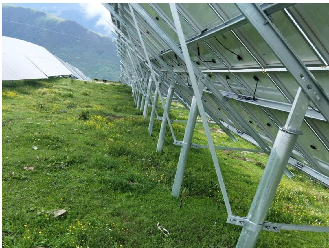
图 1-2 微型注浆钢管桩基础
