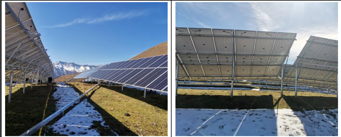
光伏阵列工程区植被建设工程
