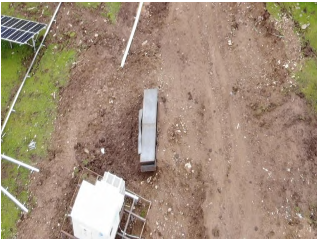
图 1-14 项目建设区土壤
