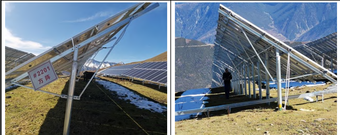
光伏阵列工程区植被建设工程
