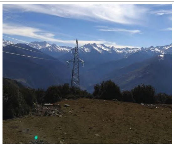
塔基植被建设工程
