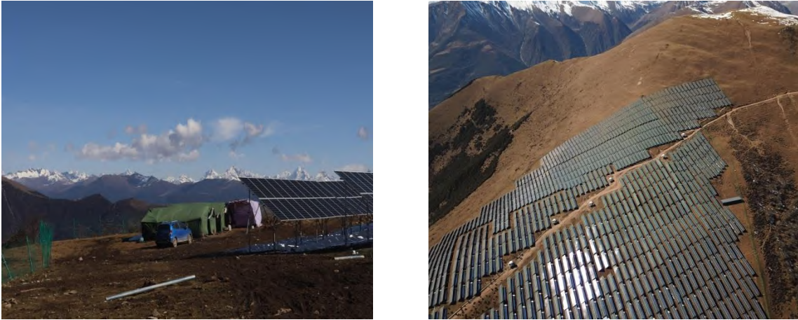
图 1-6 施工生产生活设施（现已经拆除）
